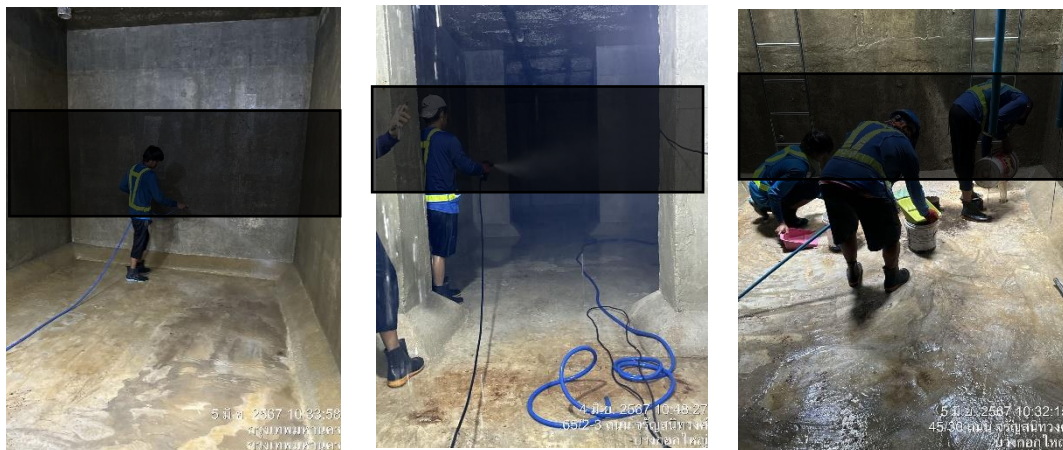
รูปที่ 3-38 ล้างทำความสะอาดถึงเก็บน้ำ เมื่อวันที่ 4-5 มิถุนายน 2567 ในปี 2568 มีแผนในเดือนกรกฎาคม
