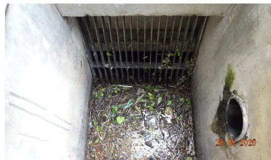
รูปที่ 3-21 ติดตั้งตะแกรงดักขยะ
