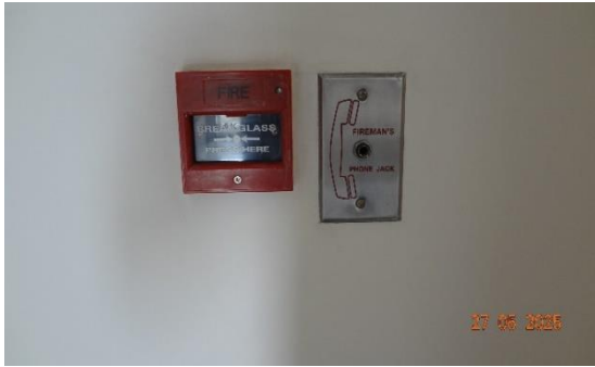
รูป 3-22.8 Manual Switch และ Telephone Jack
