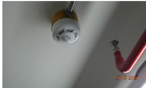
รูป 3.22.5 เครื่องจับความร้อนและสปริงเกอร์
