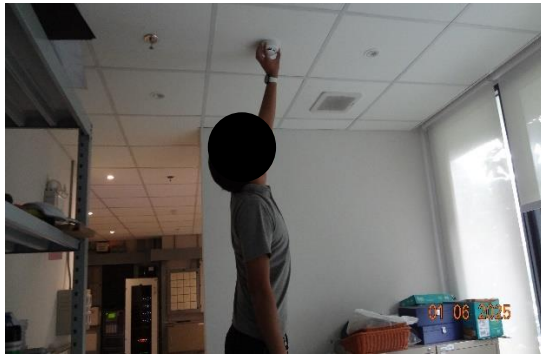
รูปที่ 3-25 เจ้าหน้าที่ตรวจสอบระบบป้องกันและเตือนอัคคีภัย
