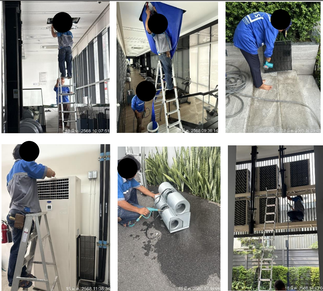
รูปที่ 3-23 ล้างเครื่องปรับอากาศและฟิเตอร์ส่วนกลาง
